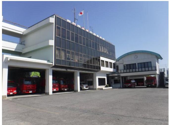
(犬山市消防本部・消防署庁舎)
