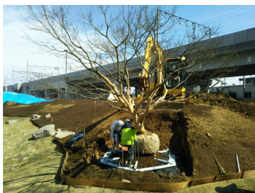
写真 6.31 地下支柱と防根シート設置状況 (史跡大友氏館跡)
