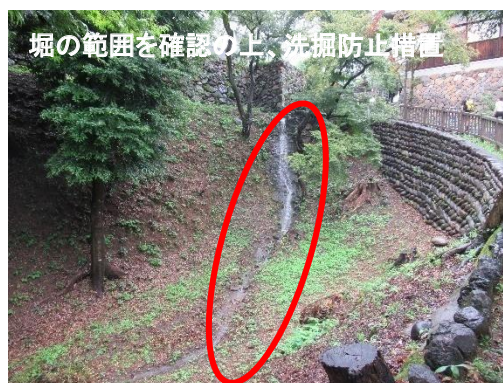
写真 6.6 排水溝から堀に流下する雨水
