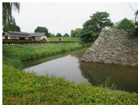
写真 6.56 堀の侵入防止植栽帯（史跡松代城跡）
