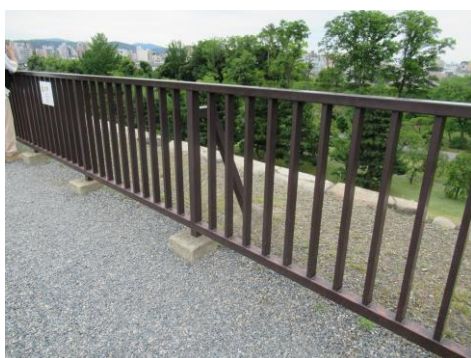
写真 6.55 櫓台の転落防止柵（史跡旧二条離宮）
