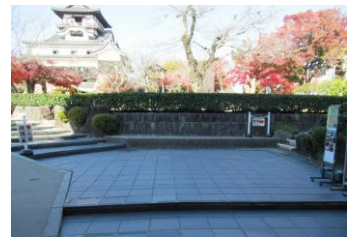
写真 4.6 鉄門内側階段(現状)
