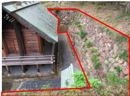
写真 4.1 改変された桐の丸北側石垣（赤枠部分）
