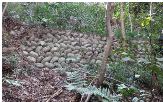
写真 4.11 現在の七曲道付近（防災擁壁の整備）
