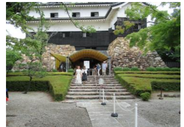
写真 4.4 天守前階段(現状)
