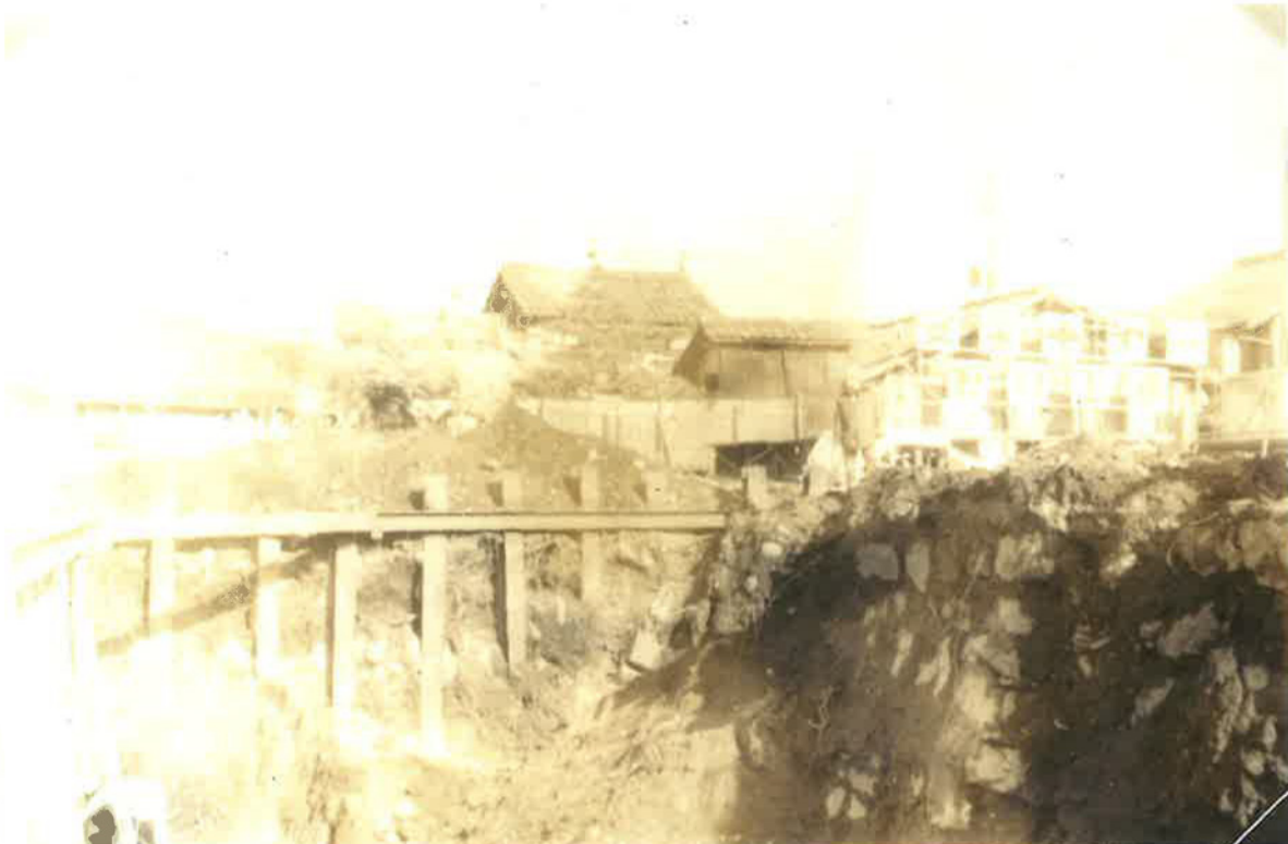
図 3.10 大山市福祉会館建設時石垣出土写真
