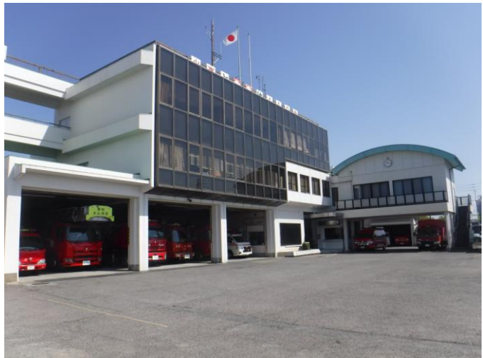
(犬山市消防本部・消防署庁舎)
