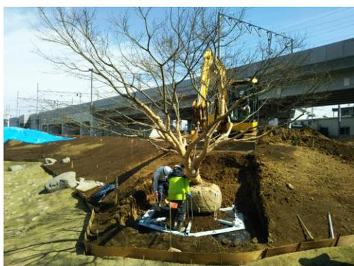
写真 6.31 地下支柱と防根シート設置状況
