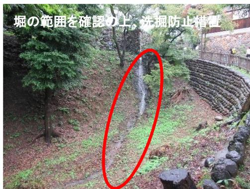
写真 6.6 排水溝から堀に流下する雨水対策
