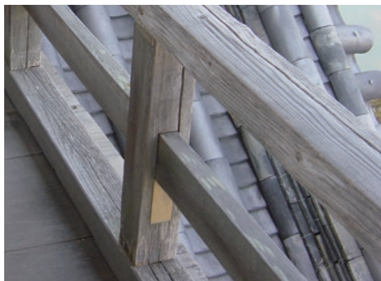
図4.44 埋木による高欄の修理
