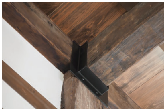
図5.18 梁仕口補強 金物取付状況 (下から見る)
