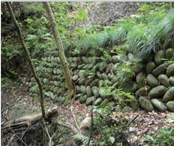
城山外縁地区 北斜面(七曲) (R2.7.3 撮影)
