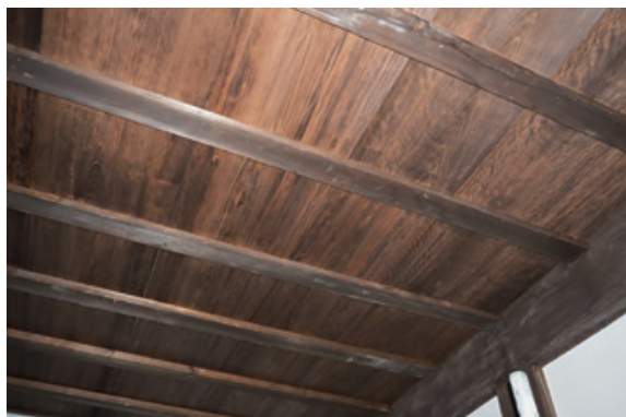
図5.16 水平構面補強、化粧板古色塗完了
