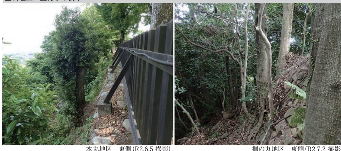
図4.47 石垣等を損傷する恐れのある樹木の例(「犬山城樹木調査(令和2年度)」より抜粋)
