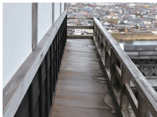
図4.43 塗装塗り直し後の四階外壁下見板
