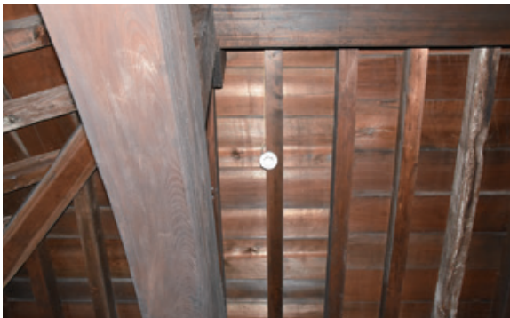
図5.11 二階煙感知器の設置位置に工夫が必要
