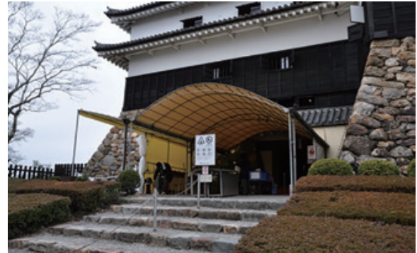
図5.10 出入口前のテント
