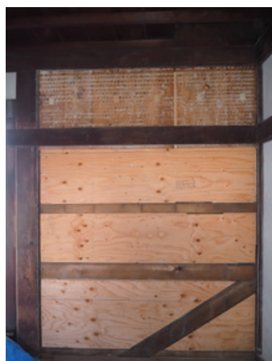
図5.20 壁補強 合板取付 (小壁は縦板復旧後の状況)
