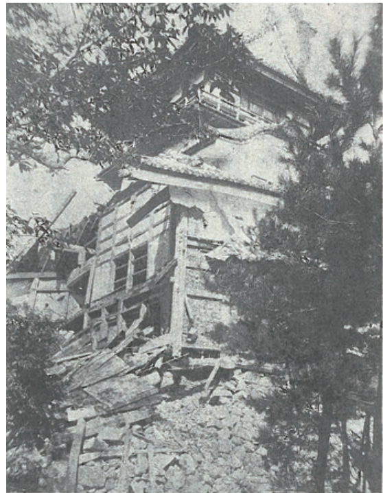
2 濃尾地震により被災した天守 明治24年(1891)頃 (『犬山市史』資料編6より転載)
