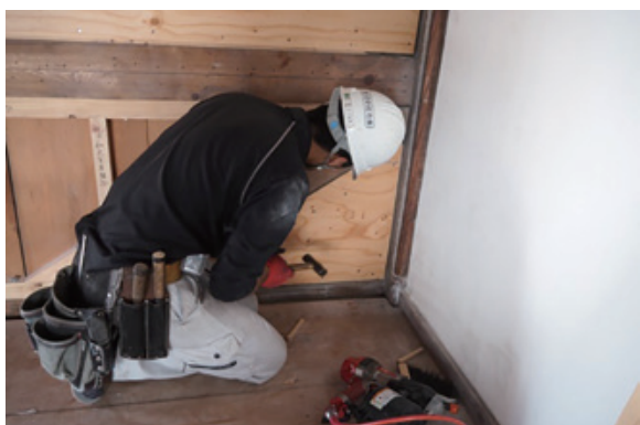
図5.19 壁補強 合板取付状況
