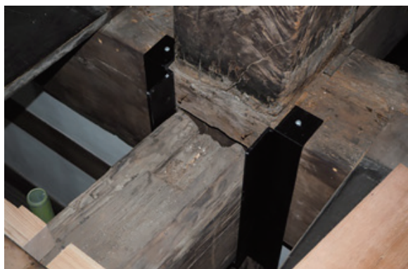
図5.17 梁仕口補強 金物取付状況 (上から見る)
