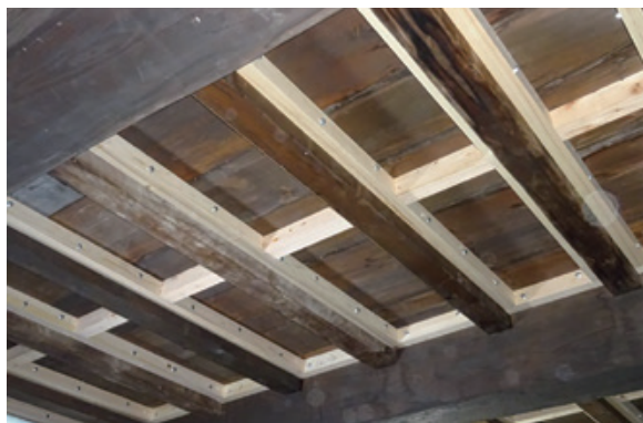
図5.15 水平構面補強、杵材固定状況
