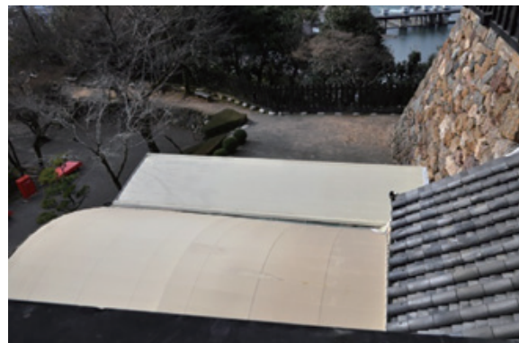
図7.2 テント屋根上部
