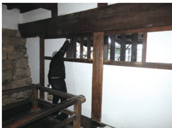
図4.42 建具枠と格子の塗装塗り直し
