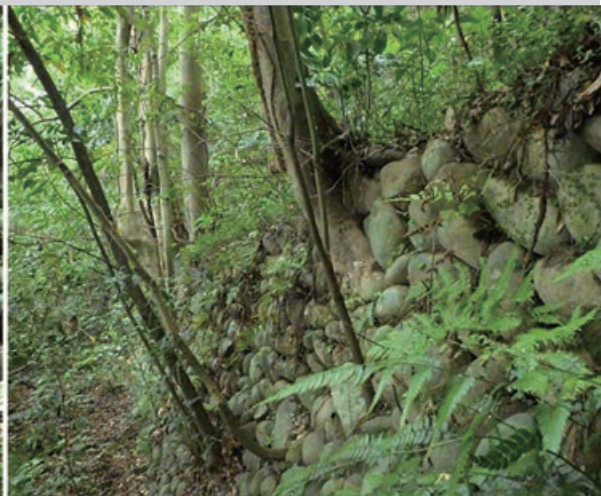
城山外縁地区 北斜面(七曲) (R2.7.3 撮影)
