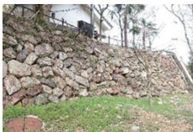
図 6.3 本丸南東側石垣
