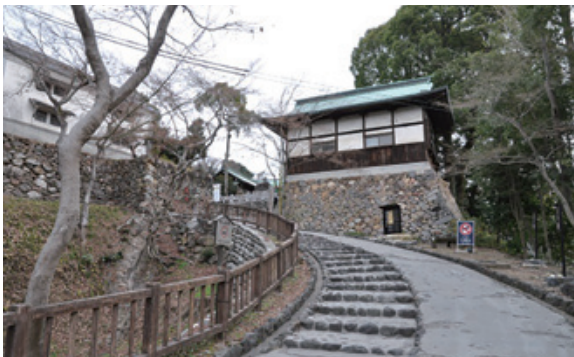
図5.13 消防車両の進入が困難な大手道
