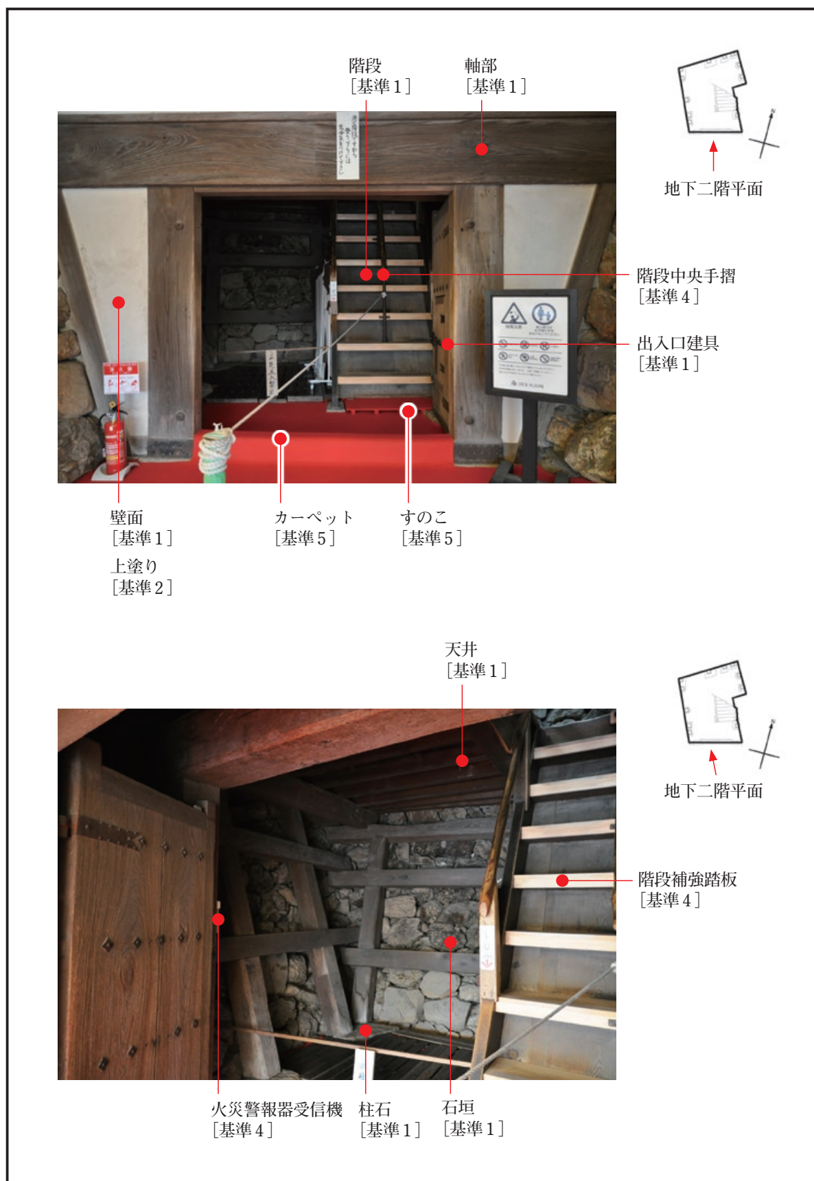
図4.25 地下二階(穴蔵)の部位の設定と保護の方針
