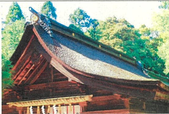
3 大縣神社拝殿 南妻面及び屋根東面
