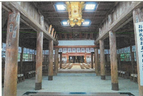
7 大縣神社拝殿 内部（身舎：南から北を見る）
