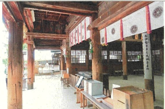
6 大縣神社拝殿 正面一間通り（東から見る）
