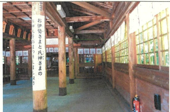
8 大縣神社拝殿 内部（東庇：南から北を見る）
