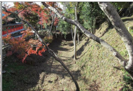
写真 6.13 堀（城山外縁西側）
