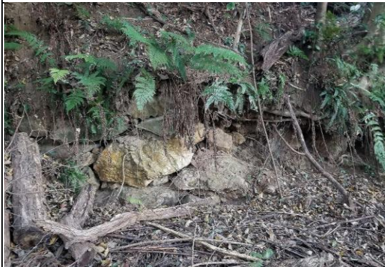
写真 6.18 埋没石垣の築石 (城山外縁東側)
