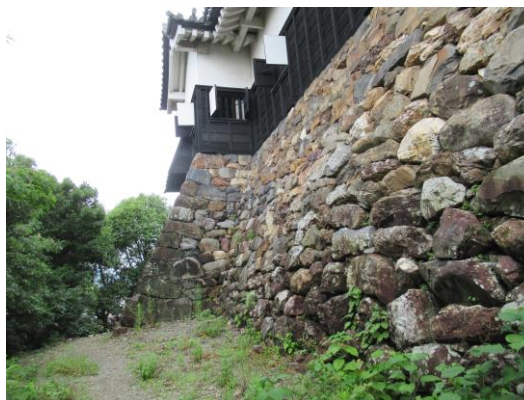
写真 6.2 天守修理に伴い解体修理された天守台石垣
