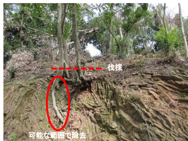
写真 6.5 切岸の保存を目的とした樹木の伐採
