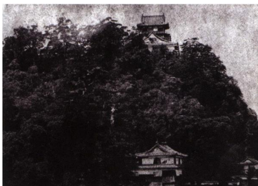
写真 6.34 木曽川上流側から見た犬山城天守 （明治6年）
