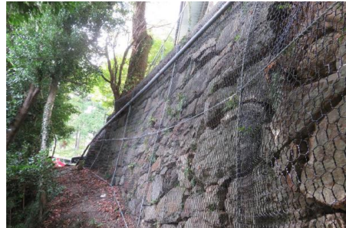
写真 6.4 ネット設置による暫定整備 (松の丸南東部)
