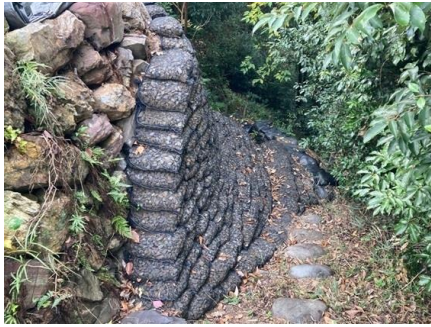
写真 6.3 砕石土嚢による石垣保護 (本丸北東部)
