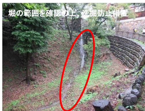
写真 6.6 排水溝から堀に流下する雨水対策
