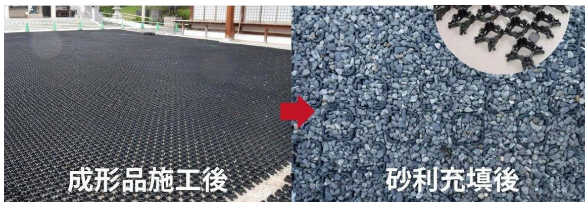
図 6.16 砂利舗装用プロテクターの敷設と砂利充填状況（出典：小林製麻株式会社）
