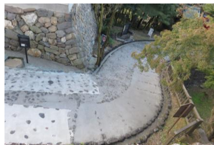
写真 4.8 後世の改変が加えられた外枅形部分（黒門跡付近）
