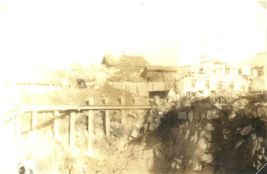
図 3.10 犬山市福祉会館建設時石垣出土写真
