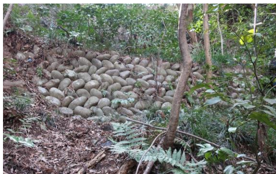
写真 4.11 現在の七曲道付近（防災擁壁の整備）
