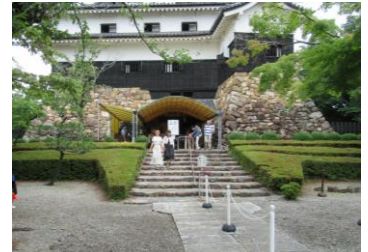
写真 4.4 天守前階段（現状）
