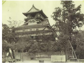
写真 4.3 天守前階段（古写真（昭和30年代中頃））
