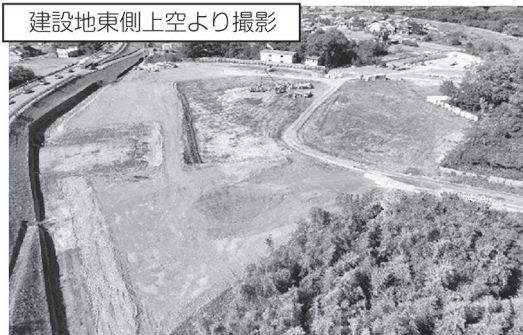
雨水調整池の整備状況
