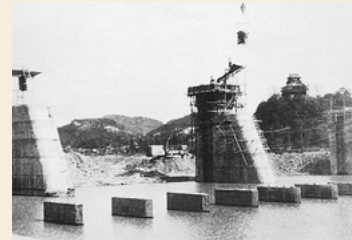
ライン大橋の建設 1959(昭和34)年
