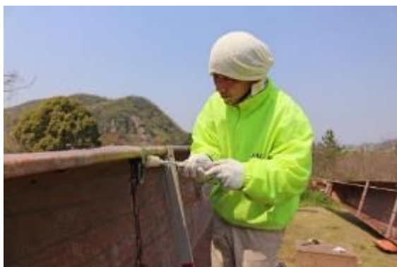
舟の修理の様子
