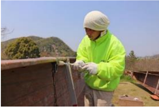
舟の修理の様子
