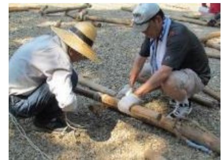
リングの組立ての様子
