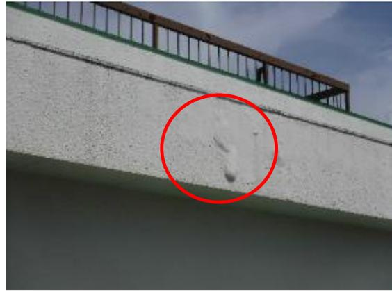
壁面のひび割れや塗装の内側に雨水が侵入し、膨張しています。
