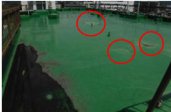
漏水により壁面塗装が膨張しています。
