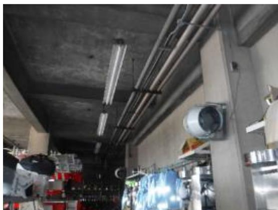
雨漏りの跡があるなど、汚損が著しいです。照明器具は腐食し、配管類の劣化も著しいです。
