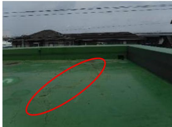
防水被膜の下に水蒸気が溜まり、被膜が膨張しています。
