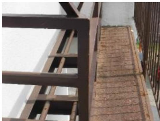
塔屋の高架水槽（写真左）のコンクリート基礎、3階のホース干し場（写真右）の足場の腐食が著しいです。
