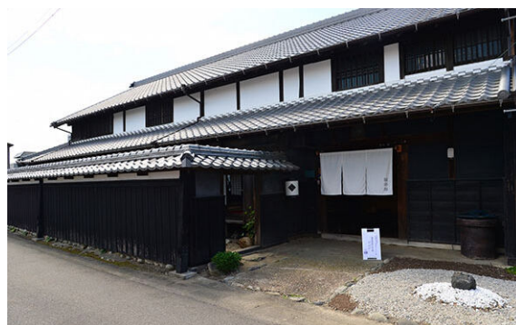
旧堀部家住宅
