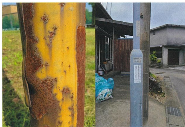
(するすみ広場外灯と道路脇の外灯の違い)
