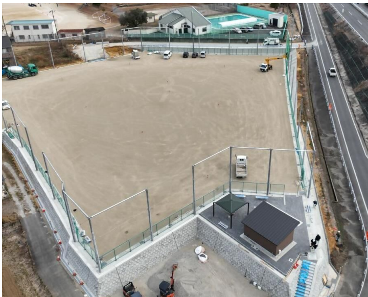
◀工事の様子 (令和7年1月30日撮影)
