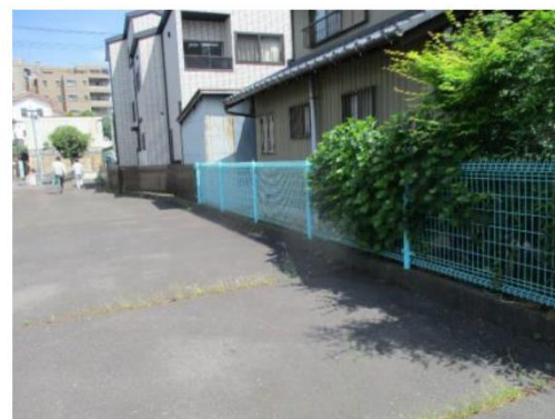
④相手方以外の隣接地と西公民館との間のフェンス
