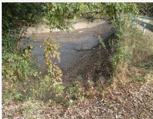
改修前のため池
