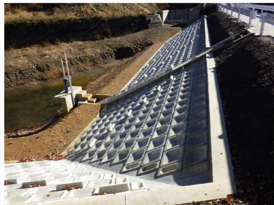
改修後のため池
