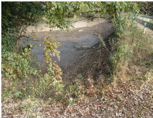
改修前のため池
