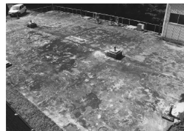
▲巨大な配水池（施設は地下）
