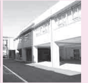
▲完成した新体育館
