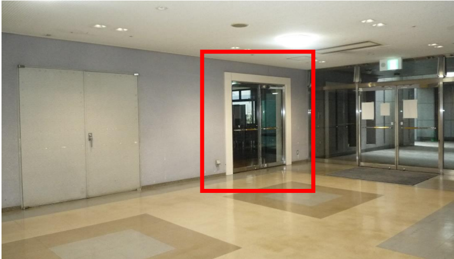
旧レストラン入口 （写真中央扉）
