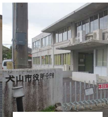
市役所分庁舎跡地 （建物解体後売却）
