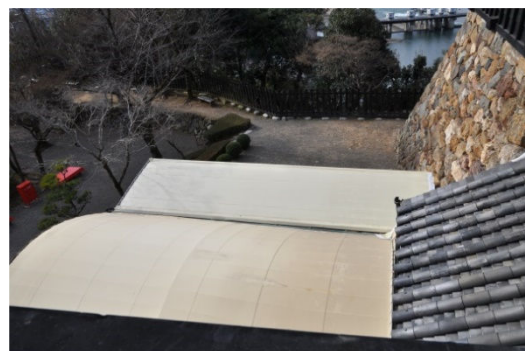
図 7.2 テント屋根上部
