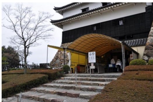
図 7.1 天守正面のテント屋根
