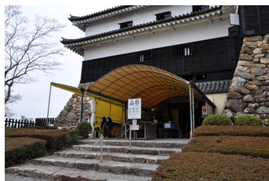
図 5.10 出入口前のテント
