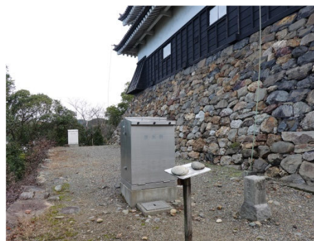
図 5.2 天守裏（北面）の放水銃
