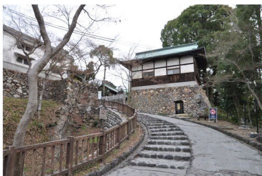
図 5.13 消防車両の進入が困難な大手道
