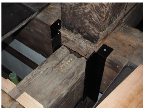
図 5.17 梁仕口補強 金物取付状況 (上から見る)
