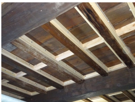
図 5.15 水平構面補強、枳材固定状況
