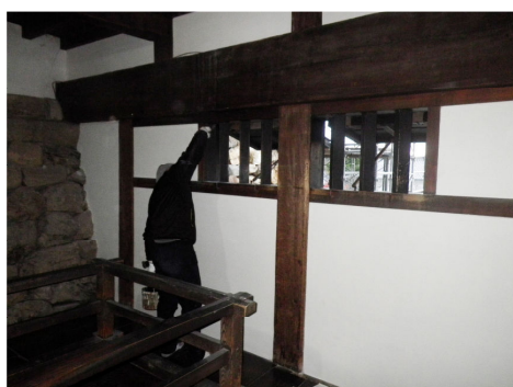
図 4.42 建具枠と格子の塗装塗り直し
