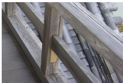
図 4.44 埋木による高欄の修理
