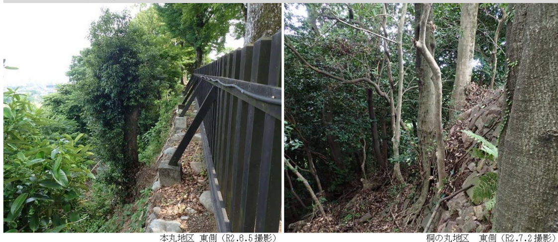
図 4.47 石垣等を損傷する恐れのある樹木の例 (「犬山城樹木調査 (令和2年度)」より抜粋)
