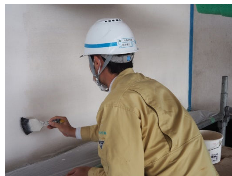
図 4.41 ノロ刷毛塗りによる漆喰の修理、『国宝犬山城天守保存修理報告書』（2020）から引用
