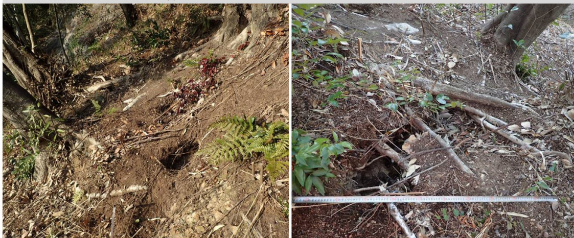
城山外縁地区 西斜面 (R2.3.3 撮影)
