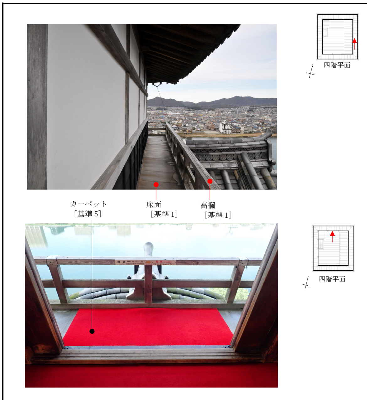
図 4.38 四階廻縁の部位の設定と保護の方針
