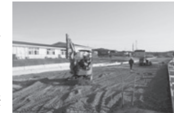
▲整備中の富岡荒井線
