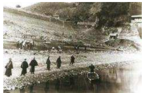
入鹿溜池 河内堤防工事の様子（明治45年）
