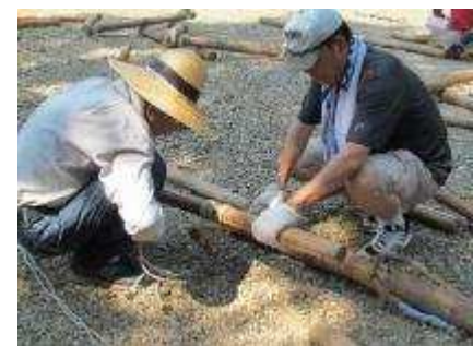
リングの組立ての様子
