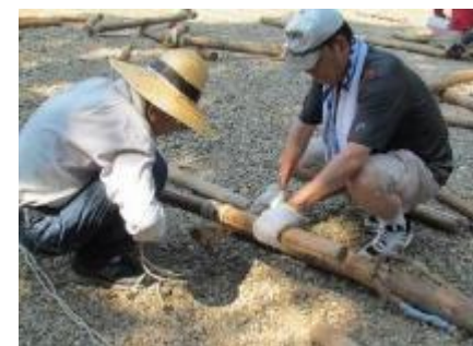
リングの組立ての様子
