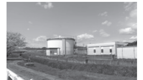
▲城東浄水場 左側のまるみを帯びた建物が水をためておく施設です。
