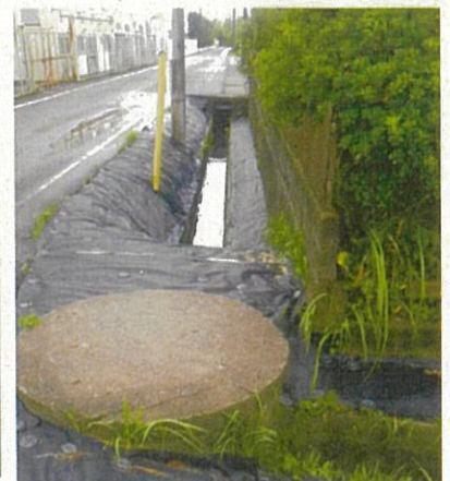
(南椿水路法面整備)
