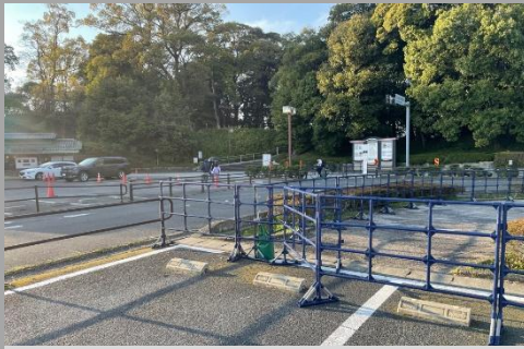
誘導用のバリケードを設置
