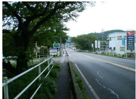
現況の出入口
