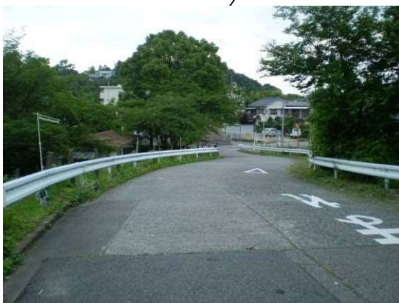
現況のアプローチ路
