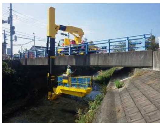
写真-3.2 専門業者による点検状況②
