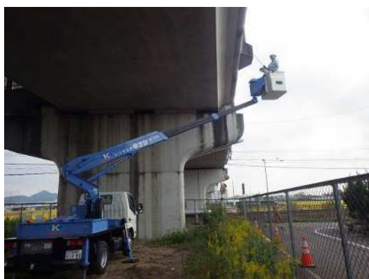
写真-3.1 専門業者による点検状況①
