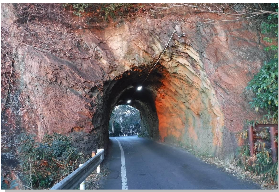
城下トンネル
