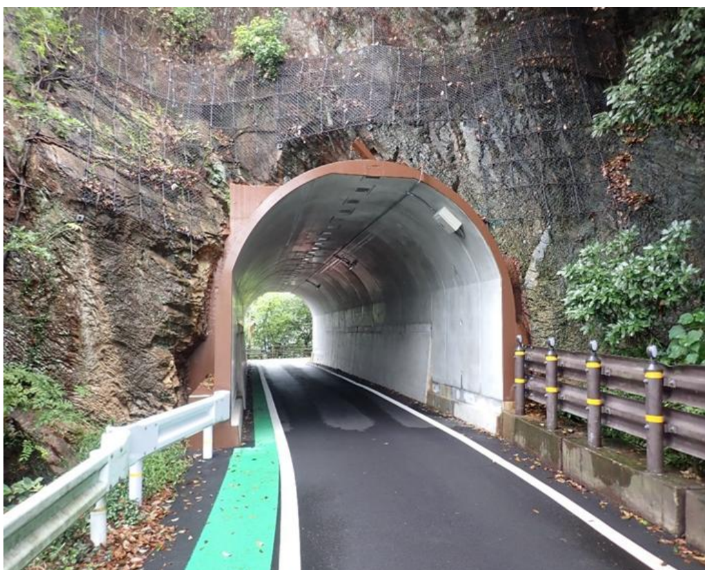
城下トンネル
