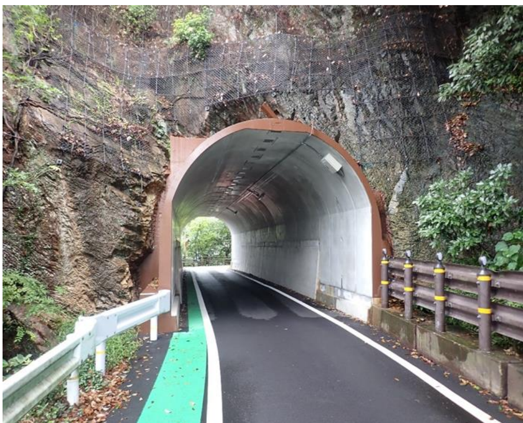
城下トンネル
