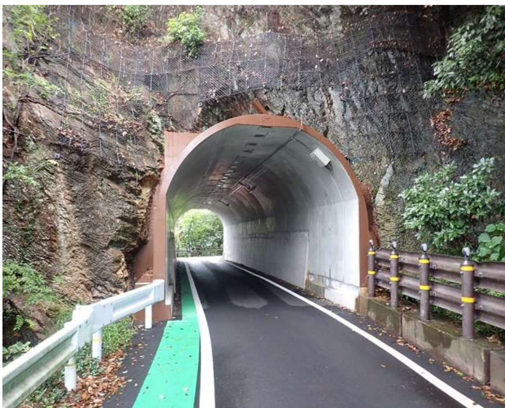
城下トンネル
