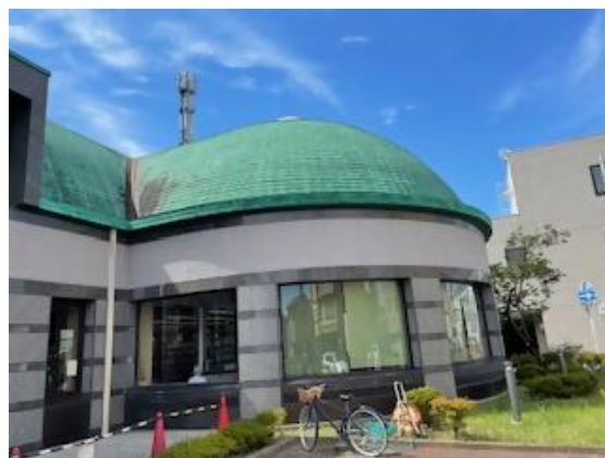
東側 R 軒樋
