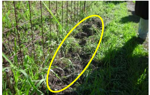
ワイヤーメッシュ柵は地際を掘られるのでしっかり固定する
