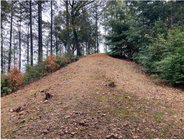
古墳前方部修復状況（下から）
