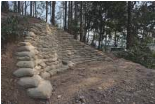
[写 4-7] 前方形埋戻し - ヤシ繊維土のう保護
