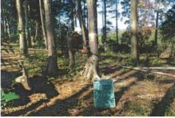
[写 4-18] 樹木伐採 - 施工状況
