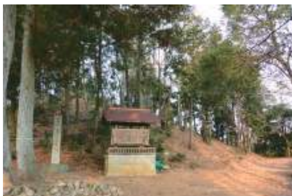
[写 4-14] 樹木伐採 - 施工前 (後方部南斜面)
