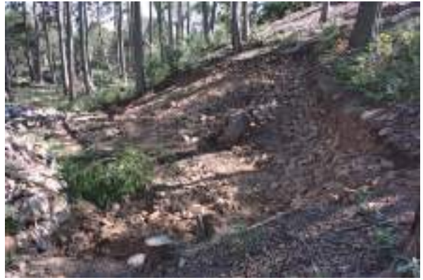
[写 4-10] 北側くびれ部埋戻し - 既設土のう撤去完了
