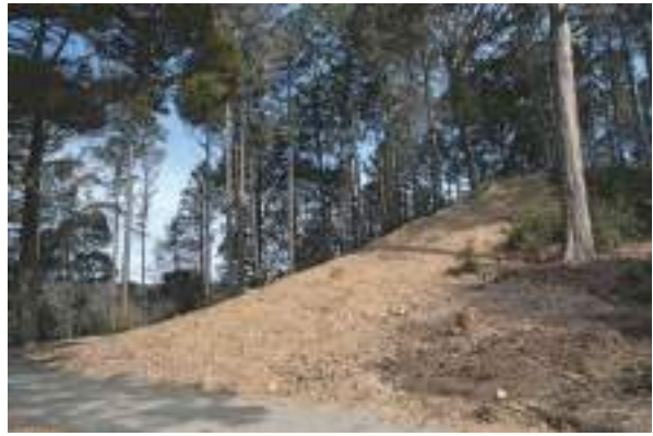
[写 4-6] 前方形埋戻し - 盛土完了
