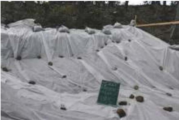
[写 4-11] 北側くびれ部埋戻し - 防根透水シート敷設
