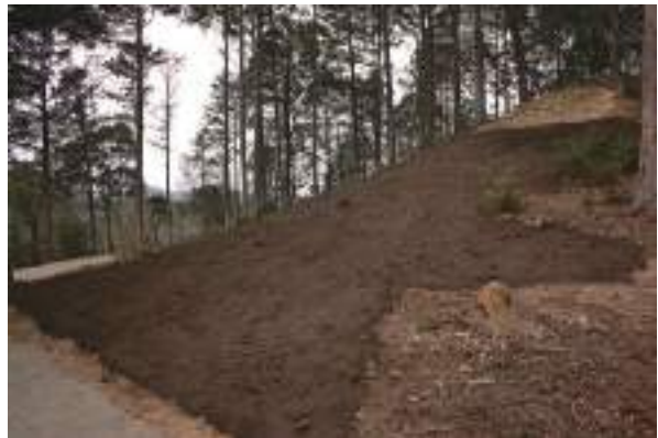
[写 4-8] 前方形埋戻し - 種子吹付完了
