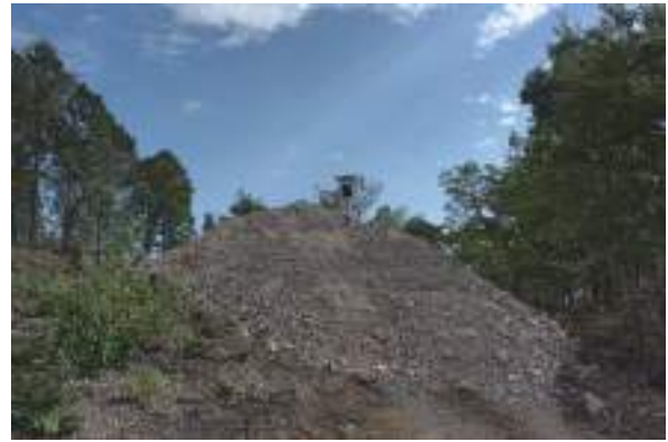
[写 4-25] 遊歩道造成 - 盛土材料 (指定地外工事残土)
