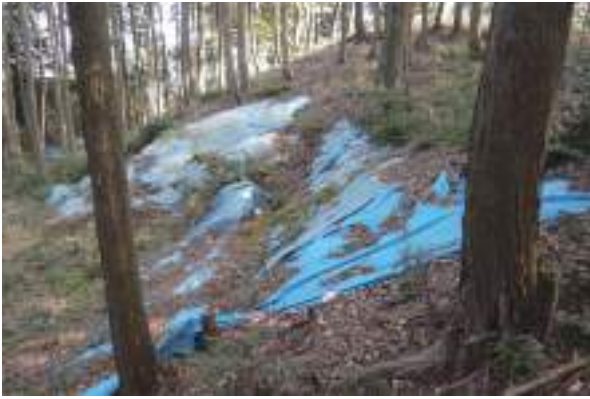
[写 4-9] 北側くびれ部埋戻し - 施工前
