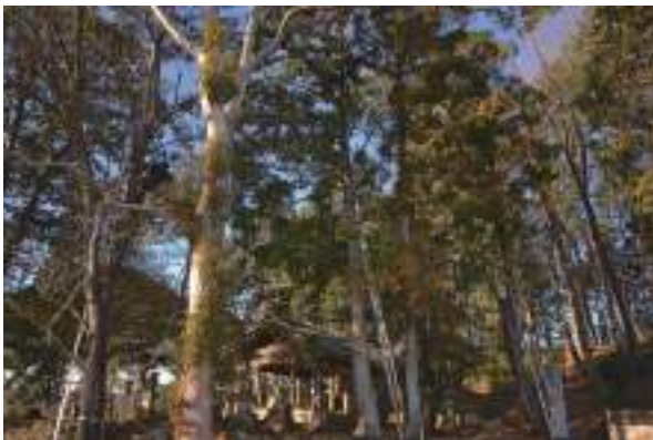
[写 4-22] 樹木剪定 - 施工状況
