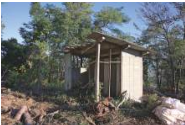
[写 4-1] 既設トイレ撤去 - 施工前
