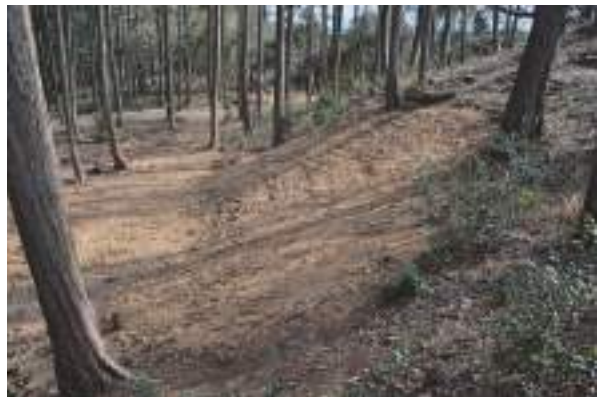
[写 4-12] 北側くびれ部埋戻し - 盛土完了
