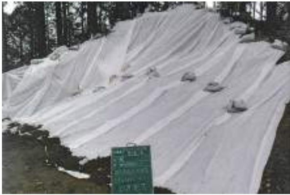
[写 4-5] 前方形埋戻し - 防根透水シート敷設
