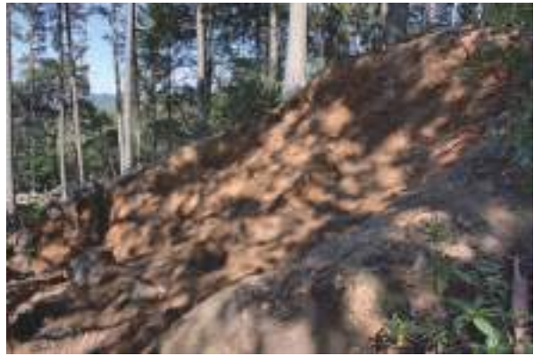
[写 4-4] 前方形埋戻し - 既設土のう撤去完了
