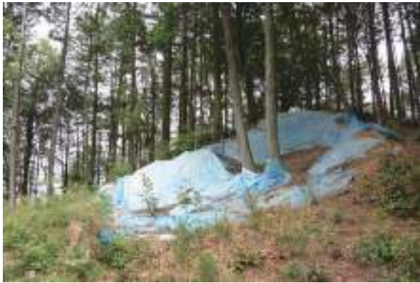
[写 4-3] 前方形埋戻し施工前
