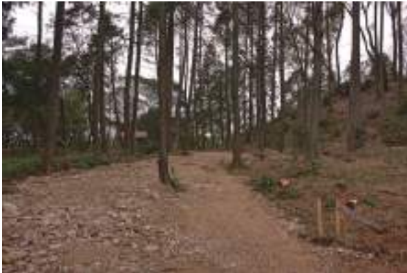
[写 4-26] 遊歩道造成 - 盛土工完了
