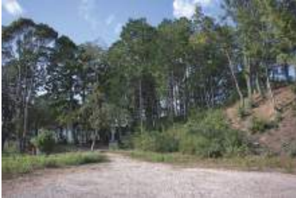
[写 4-20] 樹木剪定 - 施工前
