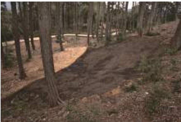
[写 4-13] 北側くびれ部埋戻し - 種子吹付完了
