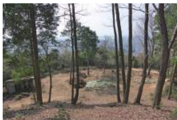
[写 4-17] 樹木伐採 - 施工後 (墳頂から南広場を望む)
