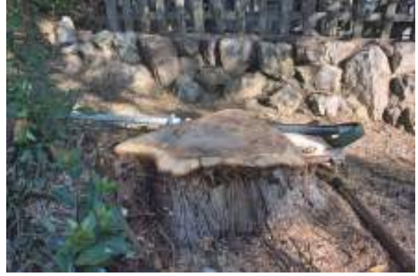
[写 4-19] 樹木伐採 - 切り株面取り
