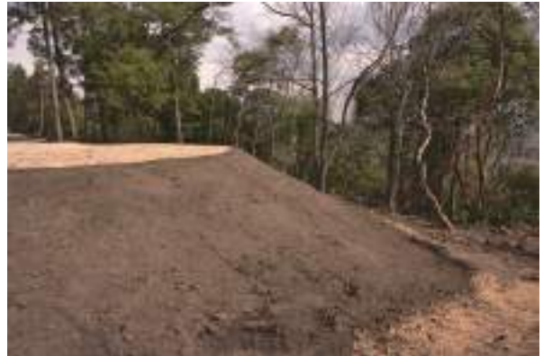
[写 4-27] 遊歩道造成 - 種子吹付完了・法面勾配
