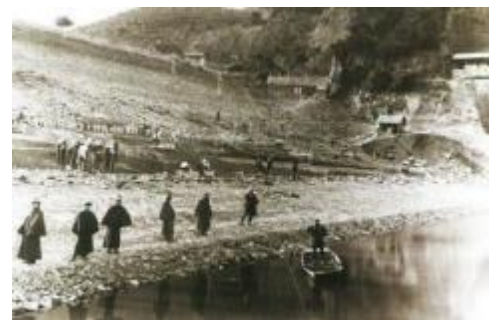
入鹿溜池 河内堤防工事の様子（明治45年）
