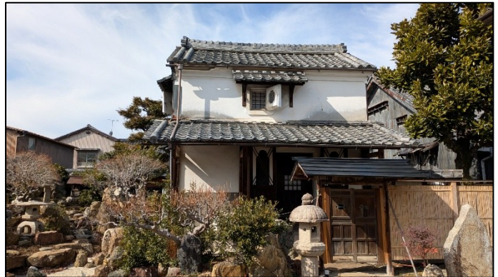
南蔵(宿泊棟)正面
