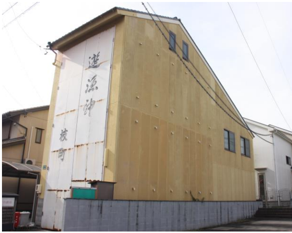
枝町車山蔵（工事前）
