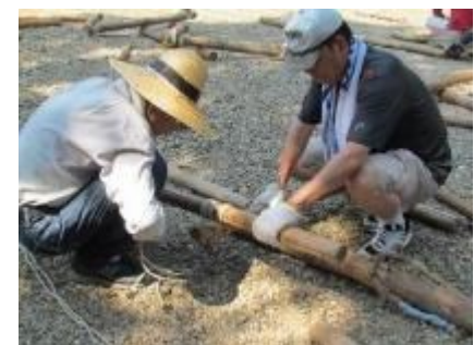
リングの組立ての様子
