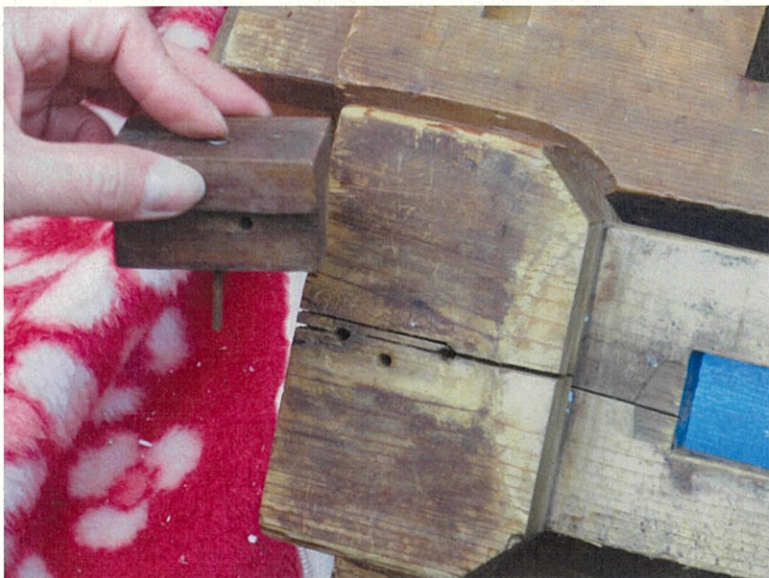
鍛冶屋町壽老臺 中山台輪端部
