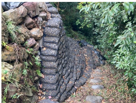
七曲付近工事完了後
