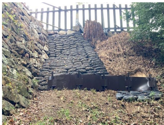
弓矢櫓跡付近工事完了後
