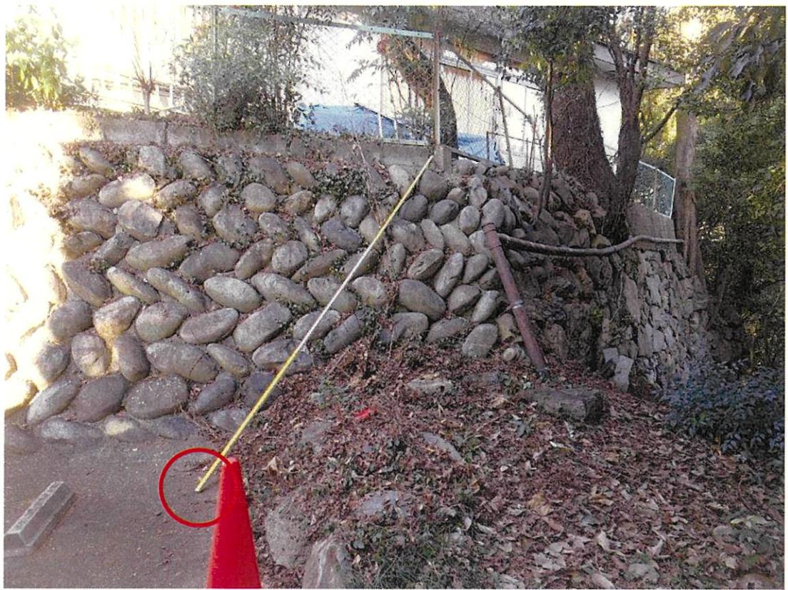
③落石防止ネットA西側（下）アンカー設置予定箇所
